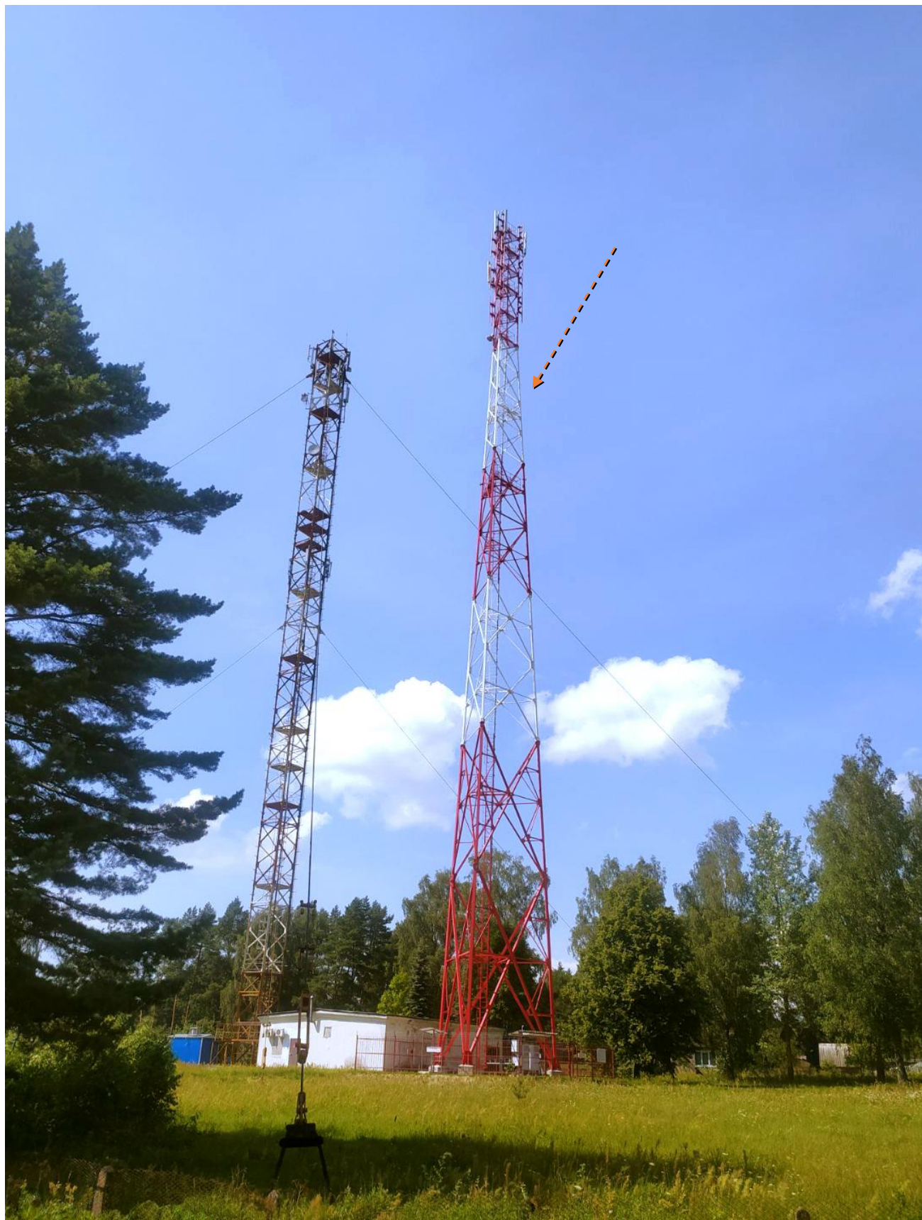
Рисунок 5 – Внешний вид существующей башни высотой 72 м ООО «Мобильные ТелеСистемы»
