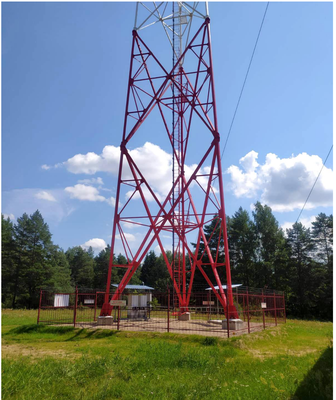
Рисунок 11 – Площадка под установку БС
