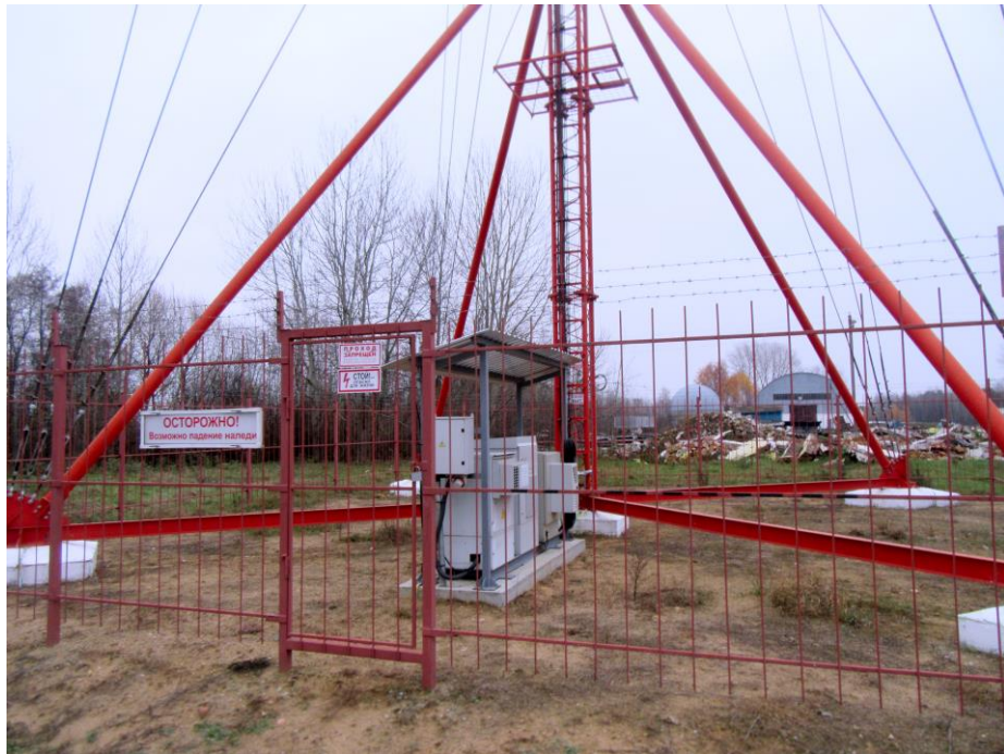
Рисунок 11 – Площадка под установку БС
