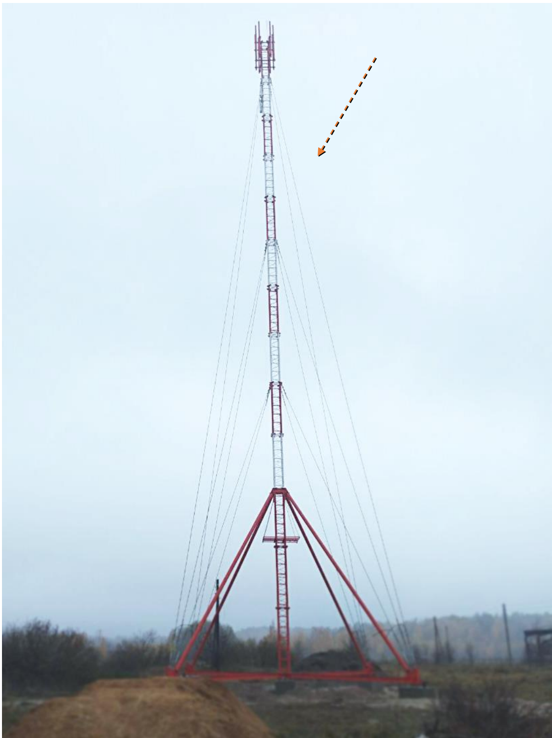
Рисунок 5 – Внешний вид существующей мачты высотой 39 м СООО «Мобильные ТелеСистемы» (объект-аналог)
